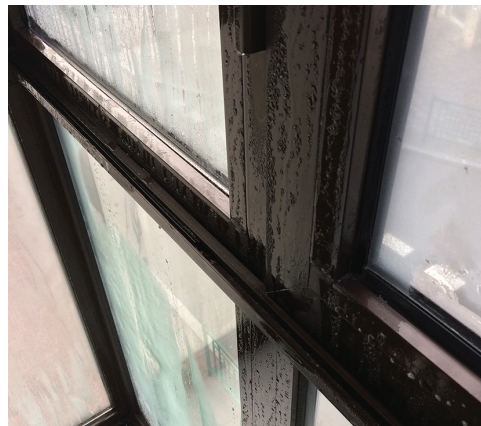
Exemple de condensation au niveau d'une menuiserie.
