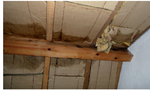
Exemple de condensation au travers de la paroi (photos prises après démontage des lambris).
